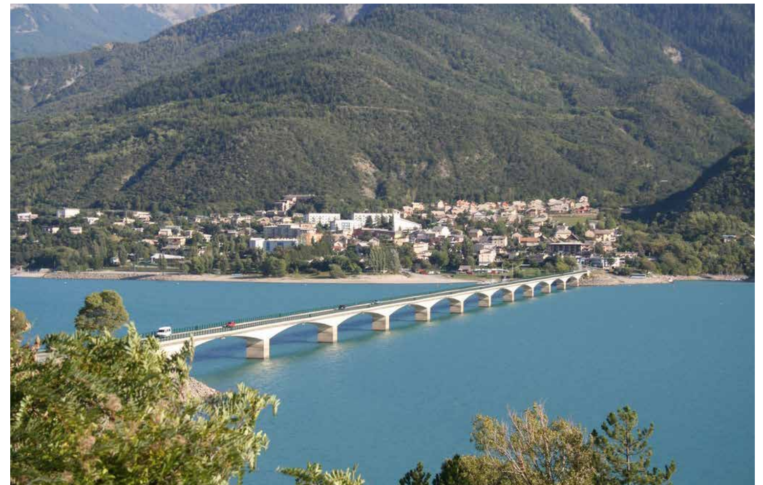
Le pont de Savines
